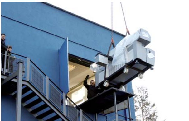
Linia do montażu SMD, firmy MYDATA, podczas umieszczania na hali produkcyjnej i już w trakcie pracy
