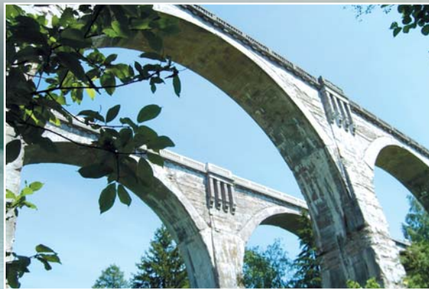
Akwedukty Puszczy Rominckiej – mosty kolejowe z początku XX wieku
