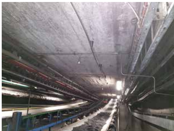
Instalacja kabla ciekącego
